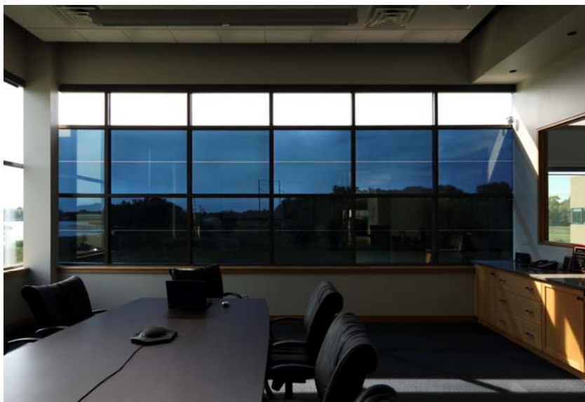
图4. 会议室中部分SageGlass玻璃窗变暗阻挡眩光，而另一部分SageGlass玻璃窗保持透明让光线进入室内取代人工照明。
