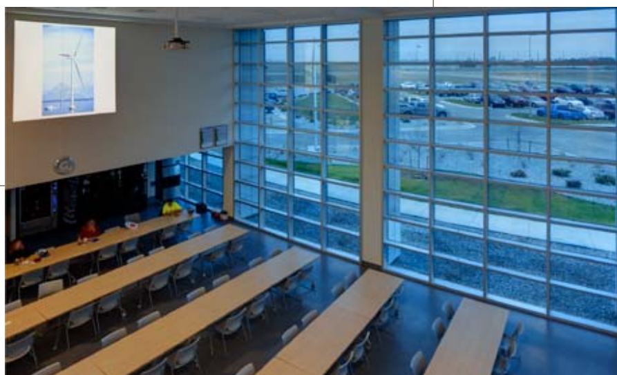
美国堪萨斯州哈钦森市西门子风力涡轮机工厂安装了SageGlass® 透明（上图）、着色（下图）
