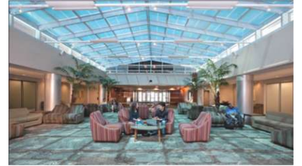
图 8：波尔州立大学的 Dehority 大厅。动态调光玻璃在全透明到全着色之间的状态，为室内保持了一定的光线水平。
