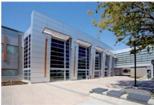
图 3：美国加州海沃德市恰博学院的学生服务中心安装了动态调光玻璃（外部景象），证明了动态调光玻璃如何让建筑师更加自由地进行设计。在该例中，使用动态调光玻璃后，该建筑得以使用自然通风系统，保留了南面和西面的全玻璃构造。
