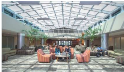
图 7：波尔州立大学的 Dehority 大厅。全动态调光玻璃屋顶提供了一个多功能的空间。本图为动态调光玻璃在透明状态下的情况。
