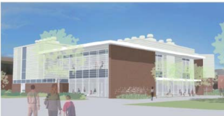
图 5：Chemeketa 健康科学中心（SRG Partnership 公司设计），30% 的屋顶是安装了动态调光玻璃的天窗，打造了一个非常充分地进行自然采光和自然通风的空间。
