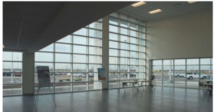
图 11：从西门子风力涡轮厂内部看到的景象。图为阴天，动态调光玻璃为全透明状态，为室内提供最多的自然光。
