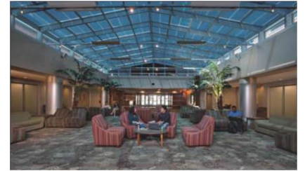
图 9：波尔州立大学的 Dehority 大厅。动态调光玻璃在全着色状态，为视频演示进行必要的光线控制。
