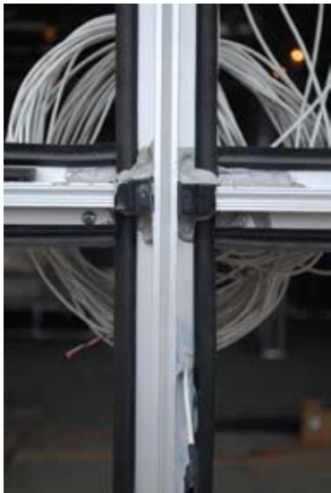
图4 在玻璃中走线的孔，用硅树脂密封固定
